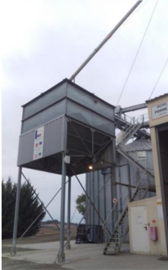
Figure 22 : Boisseau de déchargement silos S50 à S66 (fosses 2 et 3)
