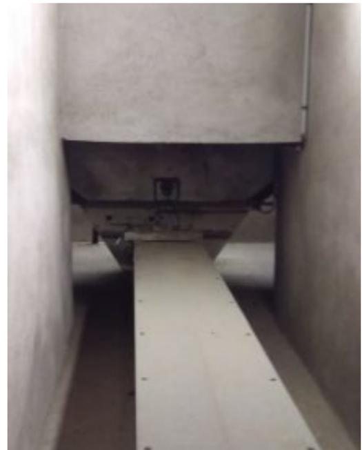
Figure 12 : Transporteur à chaîne de la fosse 1 à l'élevateur
