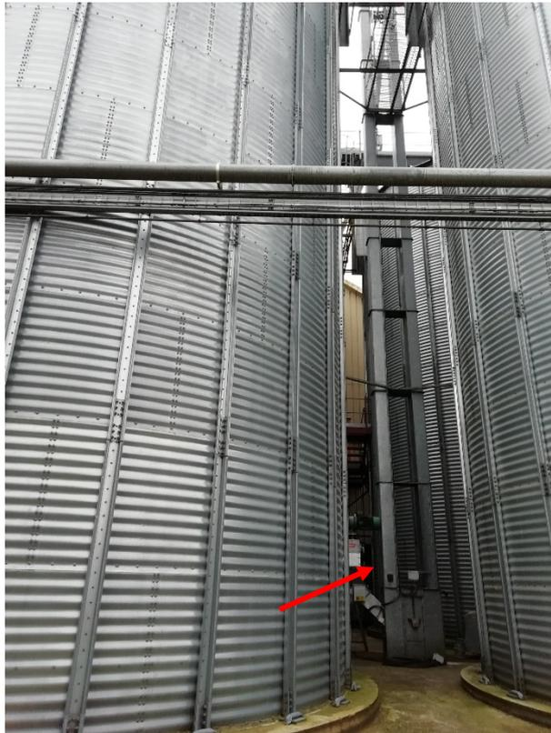
Figure 16 : Elévateur à godet situé entre les silos à l'extérieur
