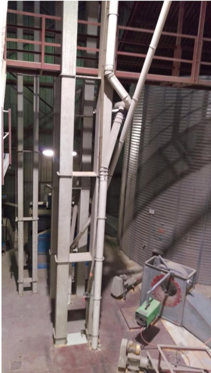
Figure 17 : Elévateur à godet dans la tour de manutention de la fosse 1
