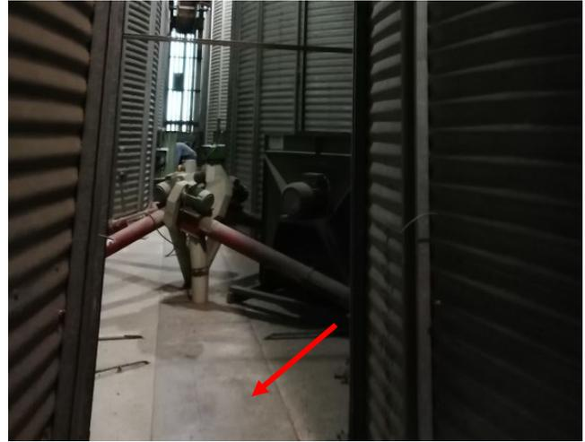
Figure 10 : Transporteur à chaîne pour vidange des silos intérieurs
