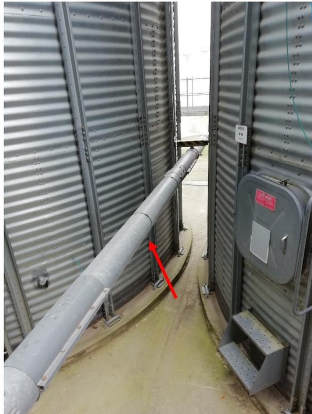
Figure 15 : Transporteur à vis pour vidange des silos extérieurs
