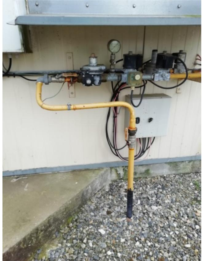
Figure 31 : Sortie de terre de la canalisation de propane
