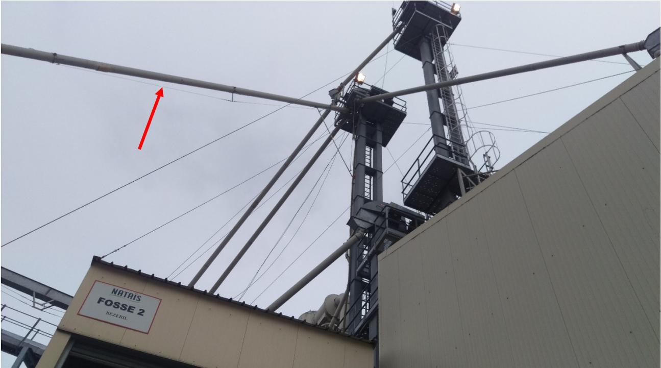
Figure 19 : Goulottes reliant les élévateurs des fosses 2 et 3 aux transporteurs à chaîne alimentant les silos
