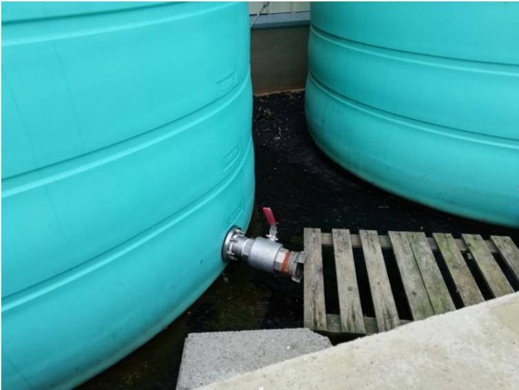
Figure 35 : Cuve d'engrais liquide sur rétention
