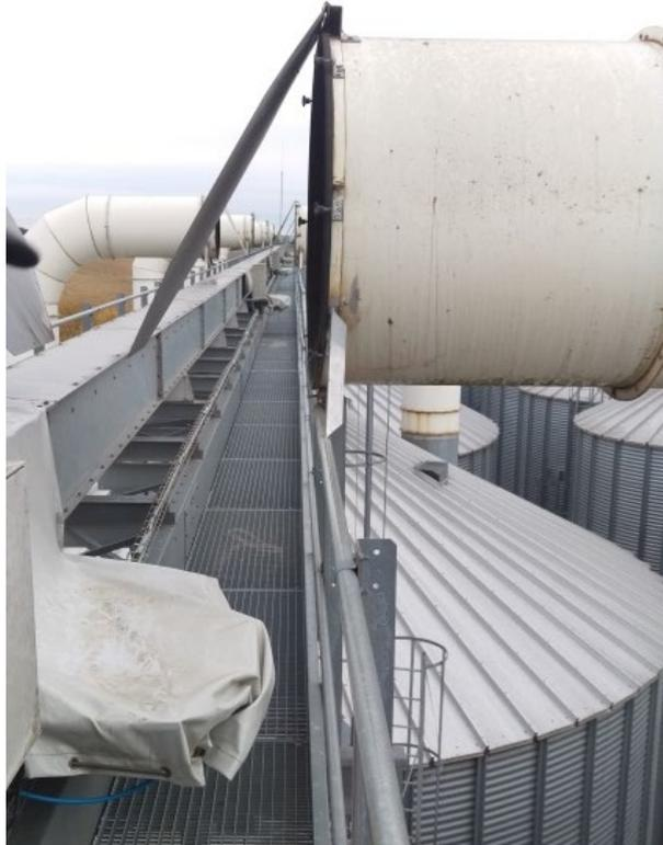
Figure 8 : Transporteur à chaîne pour approvisionnement des silos extérieurs
